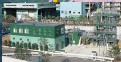
浸出水処理施設
