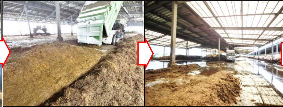
釧路市有機質肥料活用センター (堆肥センター)
