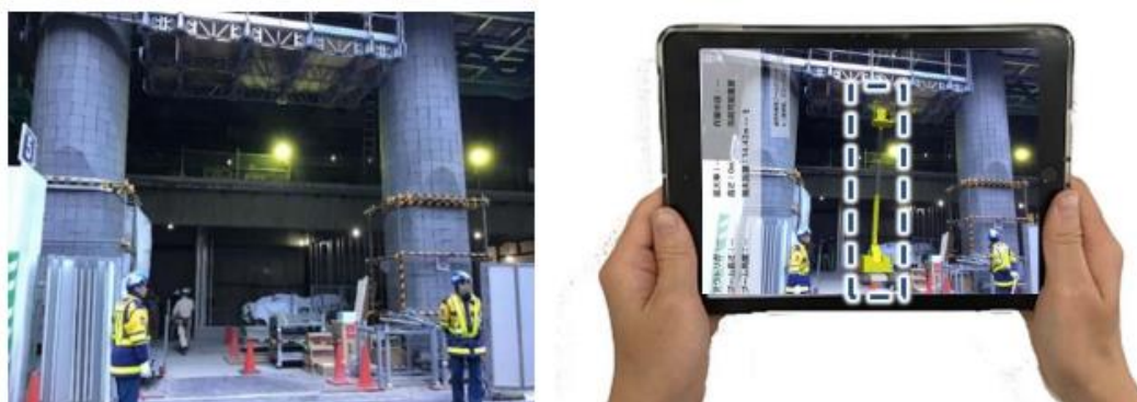
図1 3Dモデル(高所作業車)設置前後のイメージ(左：設置前、右：設置後)
